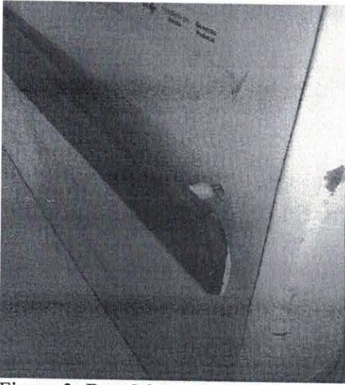
Figura 3: Bate Macas de madeira danificado e dificultando higienização.
