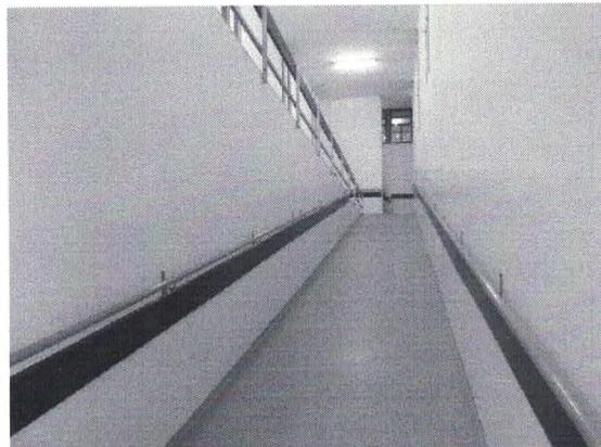
Figura 42: Nova rampa com pintura, pisos e corrimões adequados
