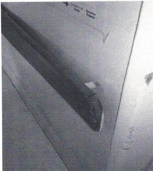
Figura 47: Bate Macas de madeira danificado e dificultando higienização.
