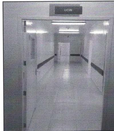
Figura 26: Piso em cerâmica e bate macas instalados.
