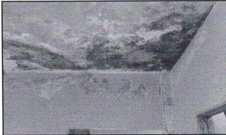
Figura 35: Infiltração no teto onde era o antigo Laboratório de Patologia.
