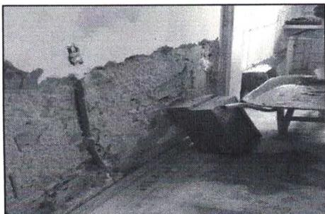
Figura 27: Paredes infiltradas
